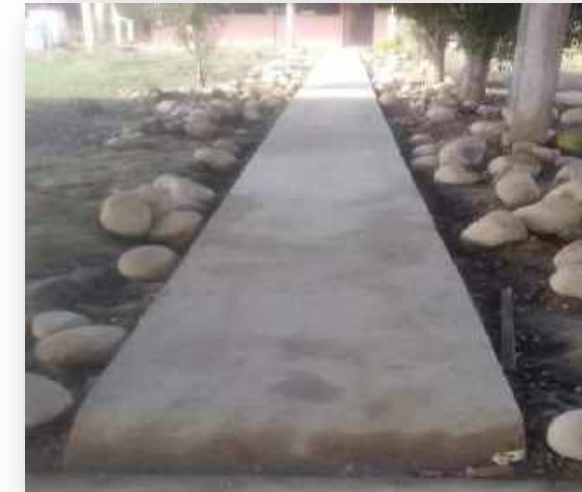
REFACCION DE U.E. ALTA VISTA, PUERTO CHORE Y PALMAR DEL NORTE
