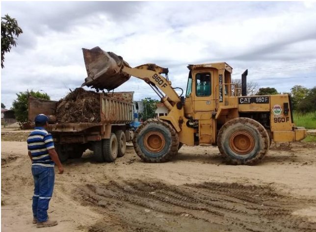
Mejoramiento y Extendido de material en B./ Heroínas sobre la circunvalación (sobre el frontis de la Dirección de Tráfico y Transporte
