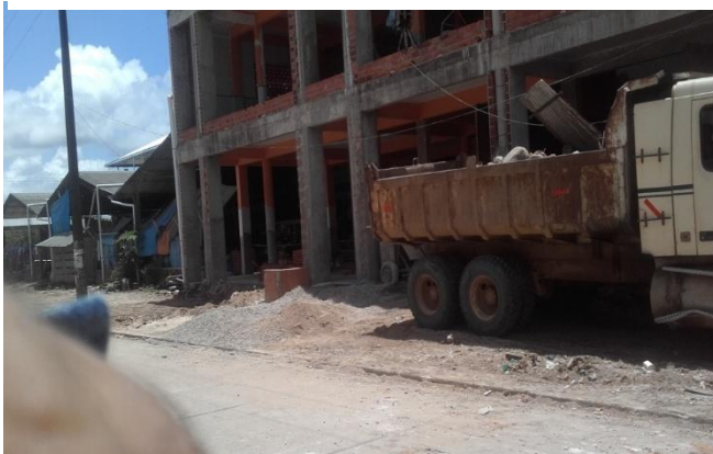
Recojo de Escombros del Mercado 1ERO DE ABRIL
