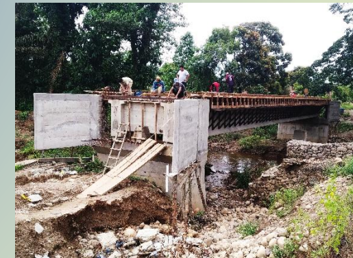
Puente Av. Santa Cruz
