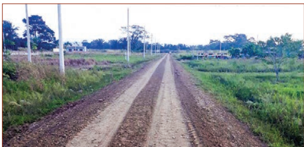
Mejoramiento de calles B. Integración del Norte
