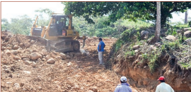
Mejoramiento de camino Moiler Abaroa
