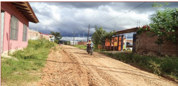
Mejoramiento de calles B. Santa Lucía TT
