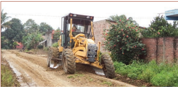
Mejoramiento de calles B. Los Pinos TT
