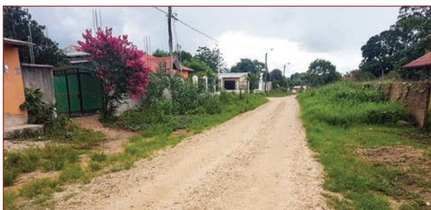
Mantenimiento de calles B. Buenos Aires
