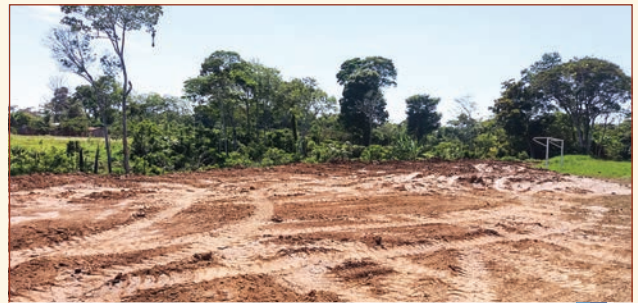
Mejoramiento cancha de fútbol en N. Horizonte
