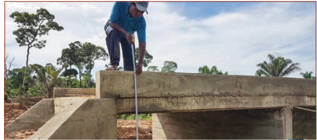
Construcción Puente cajón Sind. Víctor Paz
