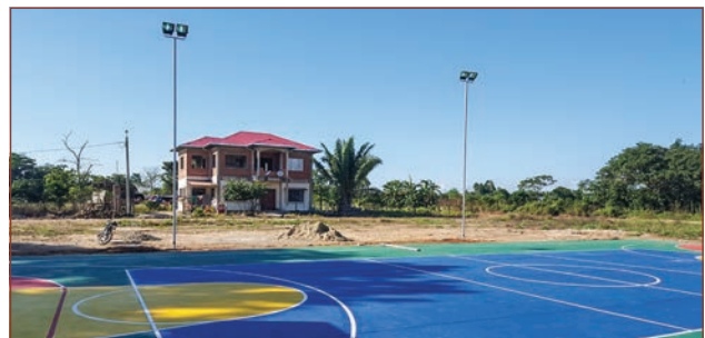
Construcción de Cancha poli funcional U.E. Buenos Aires
