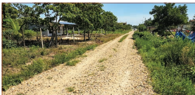
Mejoramiento de calles B. Cochabamba
