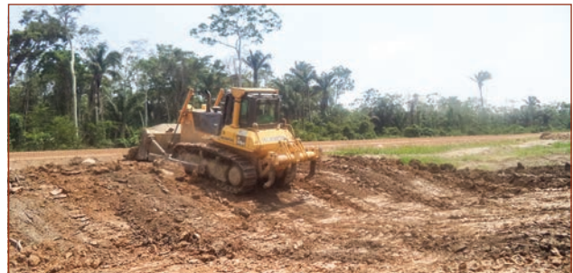
Levantamiento terraplén Central Km 18
