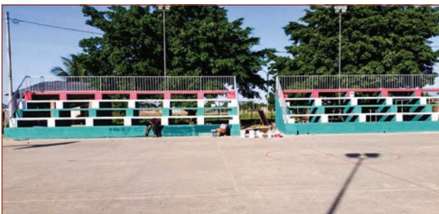
Construcción de gradería B. La Floresta
