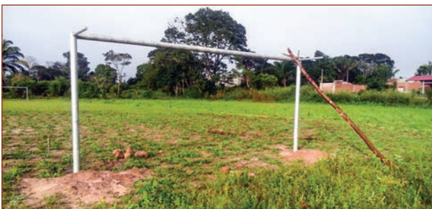
Construcción de arcos de mini fútbol B. Santa Lucía
