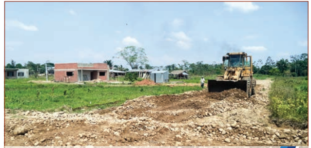
Mejoramiento de calles B. El Carmen TT
