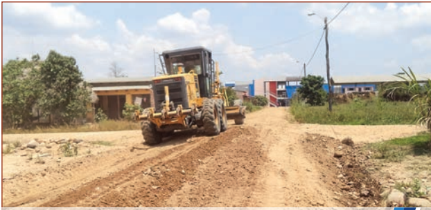
Mejoramiento de calles B. Villa Belén TT
