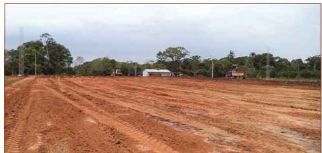
Construcción de cancha de fútbol Sind. Cóndor
