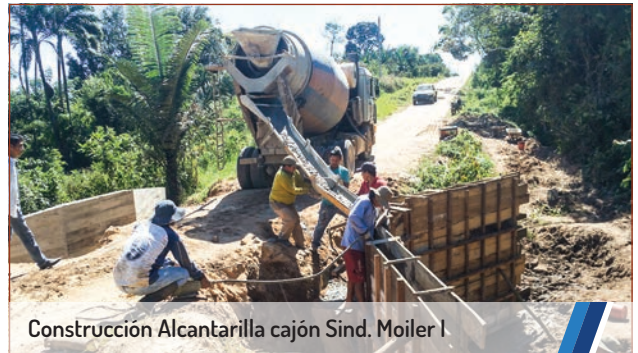
Mejoramiento de camino y alcantarilla cajón Km. 35 F. Norte
